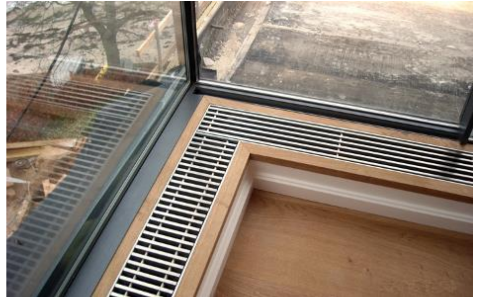
Tværgående samt langsgående lameller i rustfrit stål.
