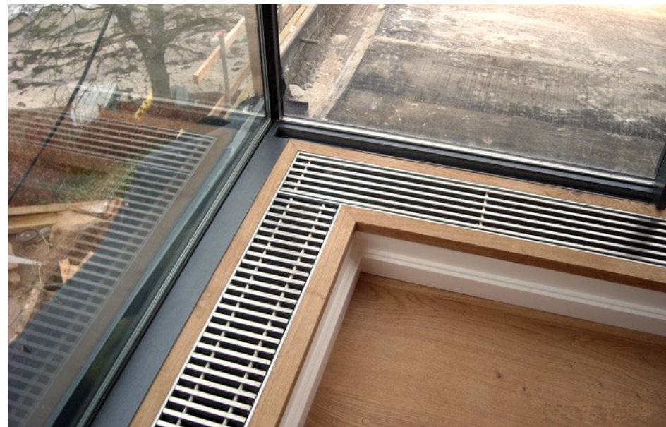
Tværgående samt langsgående lameller i rustfrit stål.
