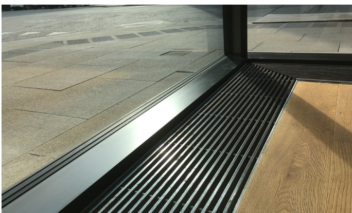
Langsgående stålrister i ubehandlet stål.
